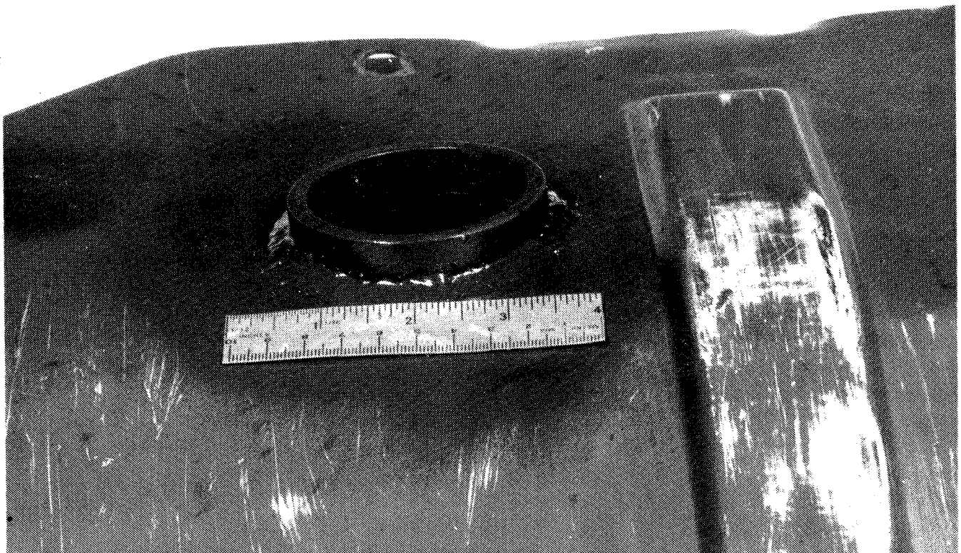
Figure 2 Access Hole with Deflector Welded to Oil Pan Protector Plate Déflecteur soudé devant le trou d'accès de la plaque protectrice du carter d'huile
